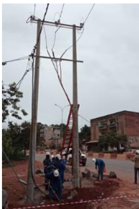
Yaoundé: Remplacement des poteaux bois critiques par des poteaux béton à Emana et environs
