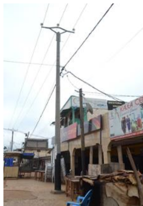
Yaoundé: Remplacement des poteaux bois critiques par des poteaux béton à Emana et environs
