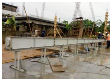
Fabrication des poteaux béton à Yassa - Douala
