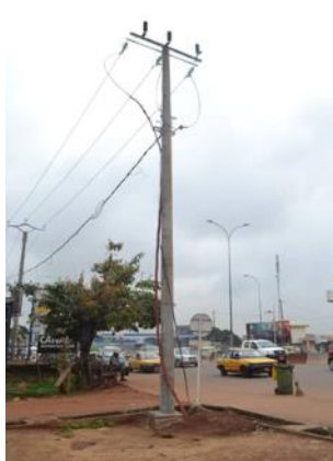
Yaoundé: Remplacement des poteaux bois critiques par des poteaux béton à Emana et environs
